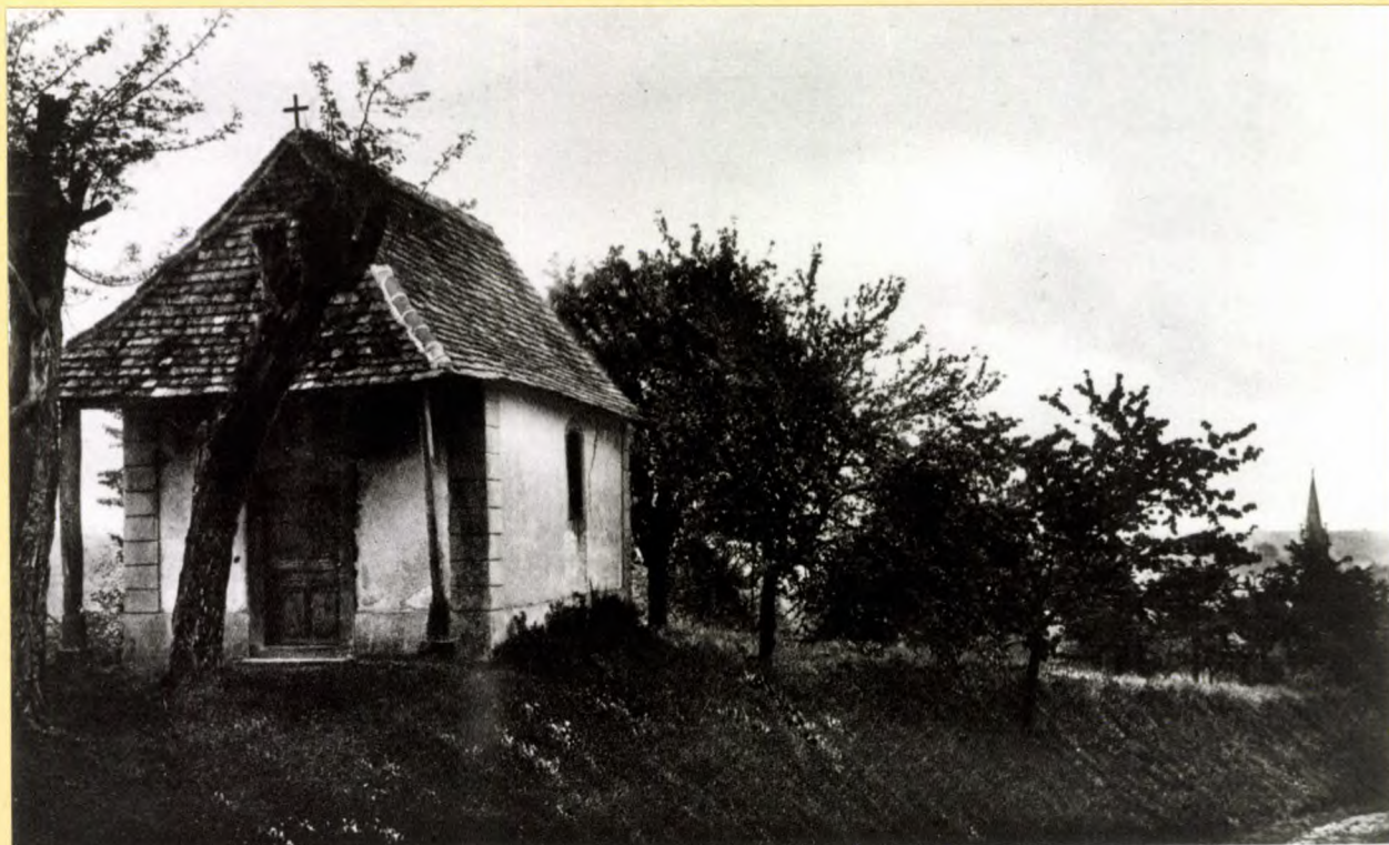
1 RODEREN — CHAPELLE «Maria auf dem Rain» ÉDIFIÉE EN 1718, REMPLACÉE PAR LA NOUVELLE CHAPELLE EN 1935
